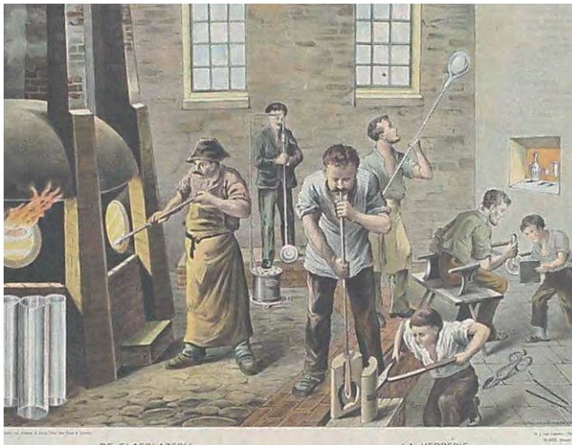
Afb. 6. Een schoolplaat van de glasblazerij. De vondsten zijn waarschijnlijk onderdeel van de ronde ovenmonden die hier zijn afgebeeld. Lummel plaat uit 1860-1921.
